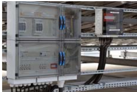
Die ENYSTAR Unterverteilungen dienen als Sammler und reduzieren den Leitungsaufwand auf lediglich fünf statt vierzig Leitungen.
